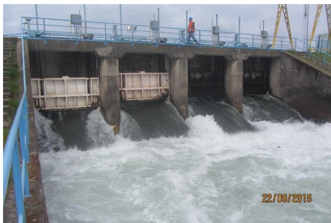
Bocatoma Canal Teno Chimbarongo
