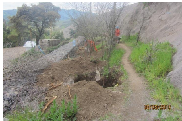
Excavación Machones Sifón Santa Adela.
