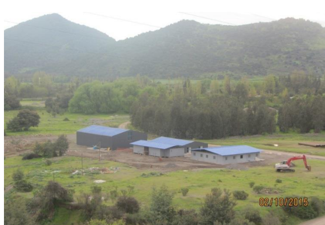
Instalación de Faenas de la CHCV. Recubrimientos Bodega, Casino y Baños.
